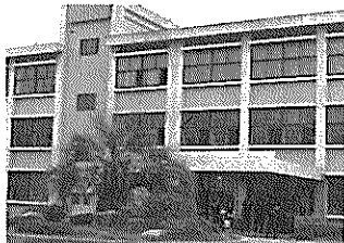
二名づつで任期は半年で、選挙は、学級から一人推薦で立候補するといふことだつた。クラブは、十八でインターアクトが、正式に認められていた。必修クラブの方は、二十以上あり我々にはない、郷土部・旅行研究部・漫画研究部など、ユニークな
