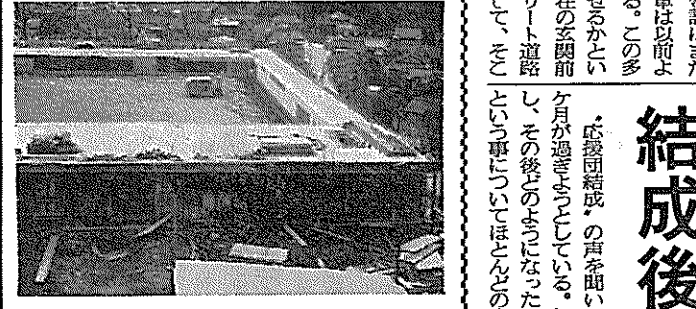
着々と進むプール工事の様子。
